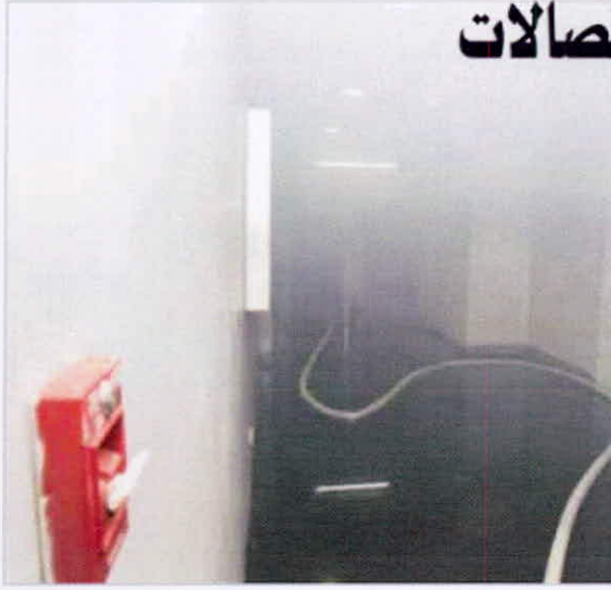
دخان الحريق انتشر في ممرات المبنى
